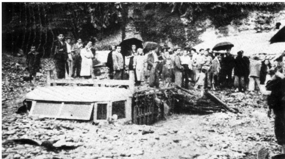
Figura 9: Camión enterrado por la avenida cuando circulaba por la calle frente a las Escuelas del Ave María (Granada).
