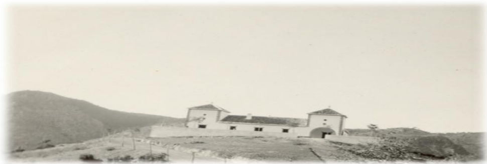
Figuras 2A y 2B. Casa forestal Los Peñoncillos, construcción del arco de entrada, 1948. Casa Forestal de Bolones 1952.
