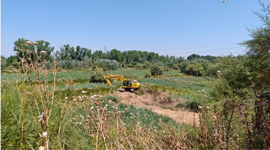
*Figura 3: maquinaria generando un camino de material seco de la orilla para poder desplazarse por el interior de la laguna.*
