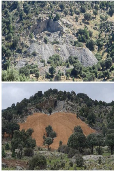
Figura 6. Arriba: cantera con anterioridad a la restauración. Abajo: aspecto tras el remodelado topográfico, extendido de suelos y revegetación
