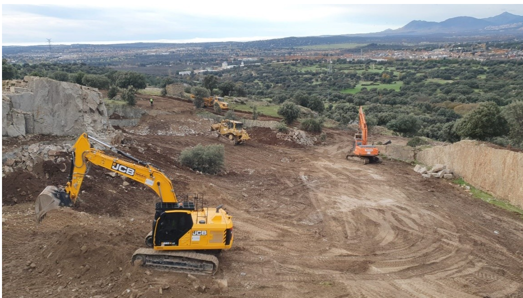
Figura 3. Maquinaria trabajando en la restauración de las canteras de granito de Alpedrete: buldócer D6, dos retroexcavadoras y camión articulado
