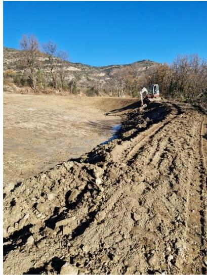
*Figura 3: Creación de las balsas para recogida de agua pluvial.*
