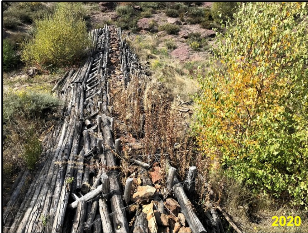
Figura 32: Fotos del estado del dique mitxo y de la evolución de la vegetación .
