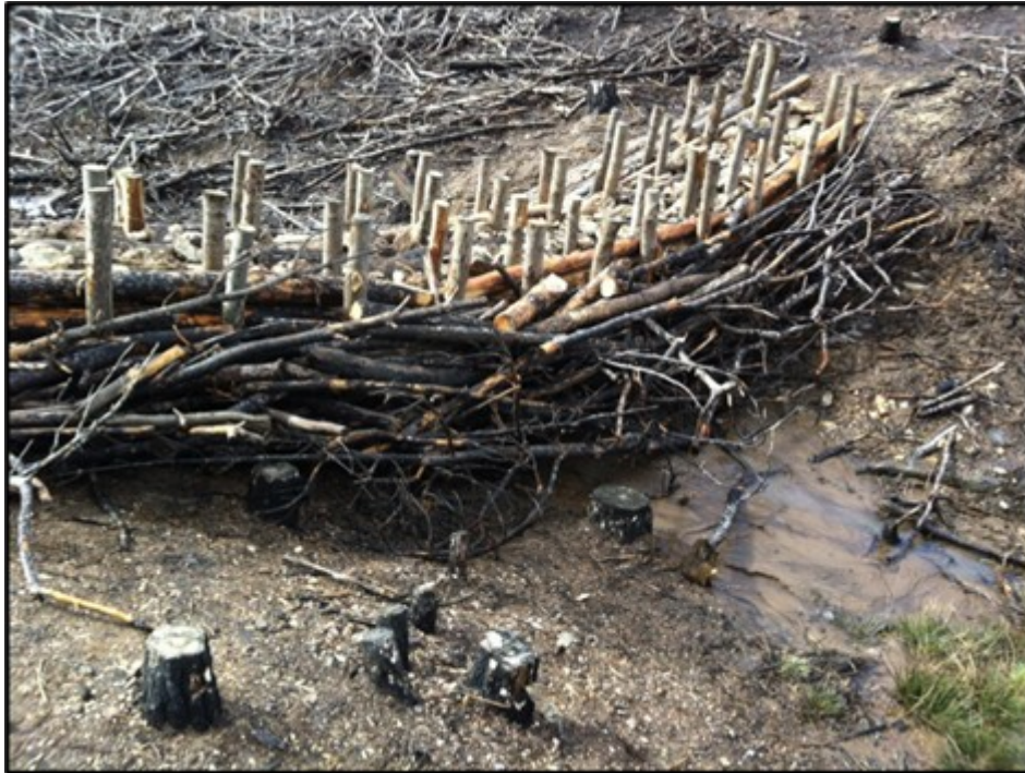
Figura 16: Fotos de la ejecución de las obras de bioingeniería de emergencias.
