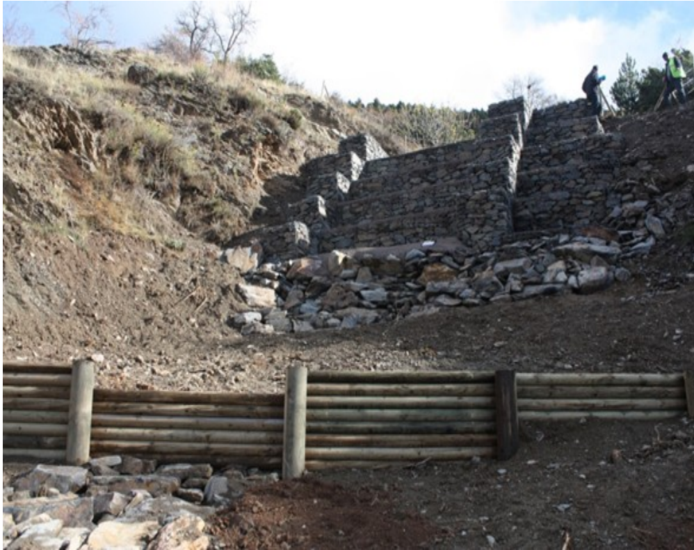
Figura 7. Foto de la primera palizada construida aguas abajo del dique de gaviones, antes de realizar la plantación y la siembra.
