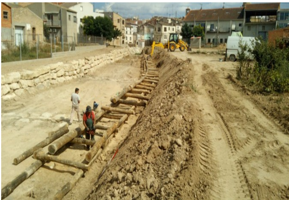
Figura 26: Foto de la construcción del muro krainer con troncos de castaño.
