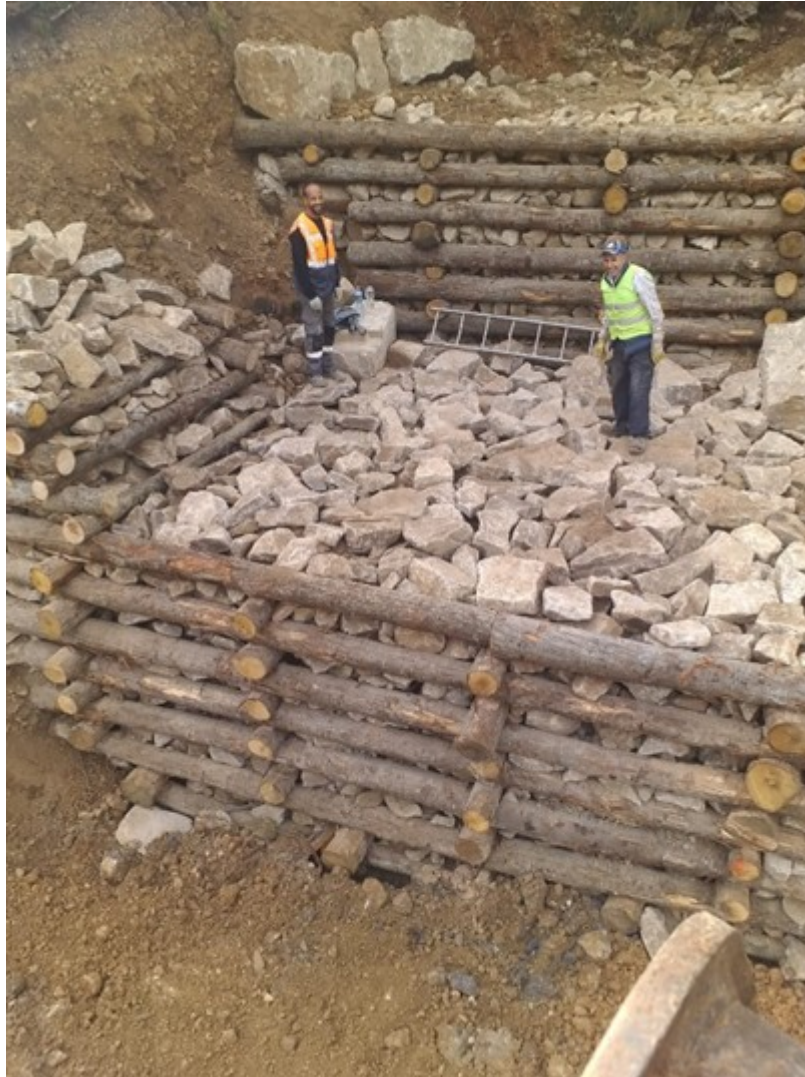
Figura 24: Fotos de la ejecución de las obras de bioingeniería.
