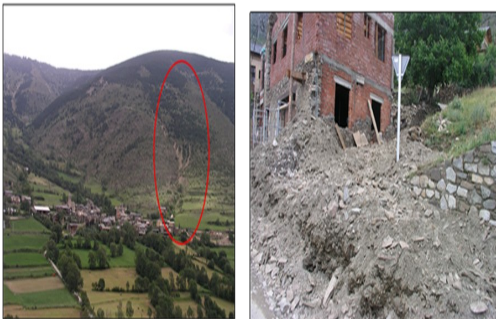
Figura 4. Vista general del torrente de les Canes con el pueblo de Meranges situado en el cono de deyección y fotos de la pista de acceso al pueblo y al monte obstruida por los acarreos movilizados en el episodio de lluvias.
