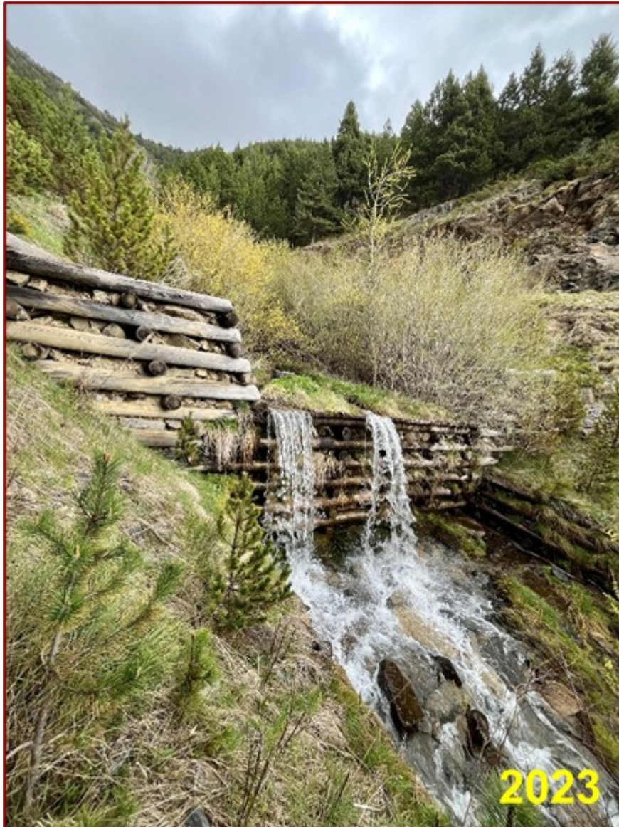
Figura 30: Foto de la evolución de los diques de consolidación, canalización lateral y de la vegetación aguas debajo de la nueva obra de paso al torrente.
