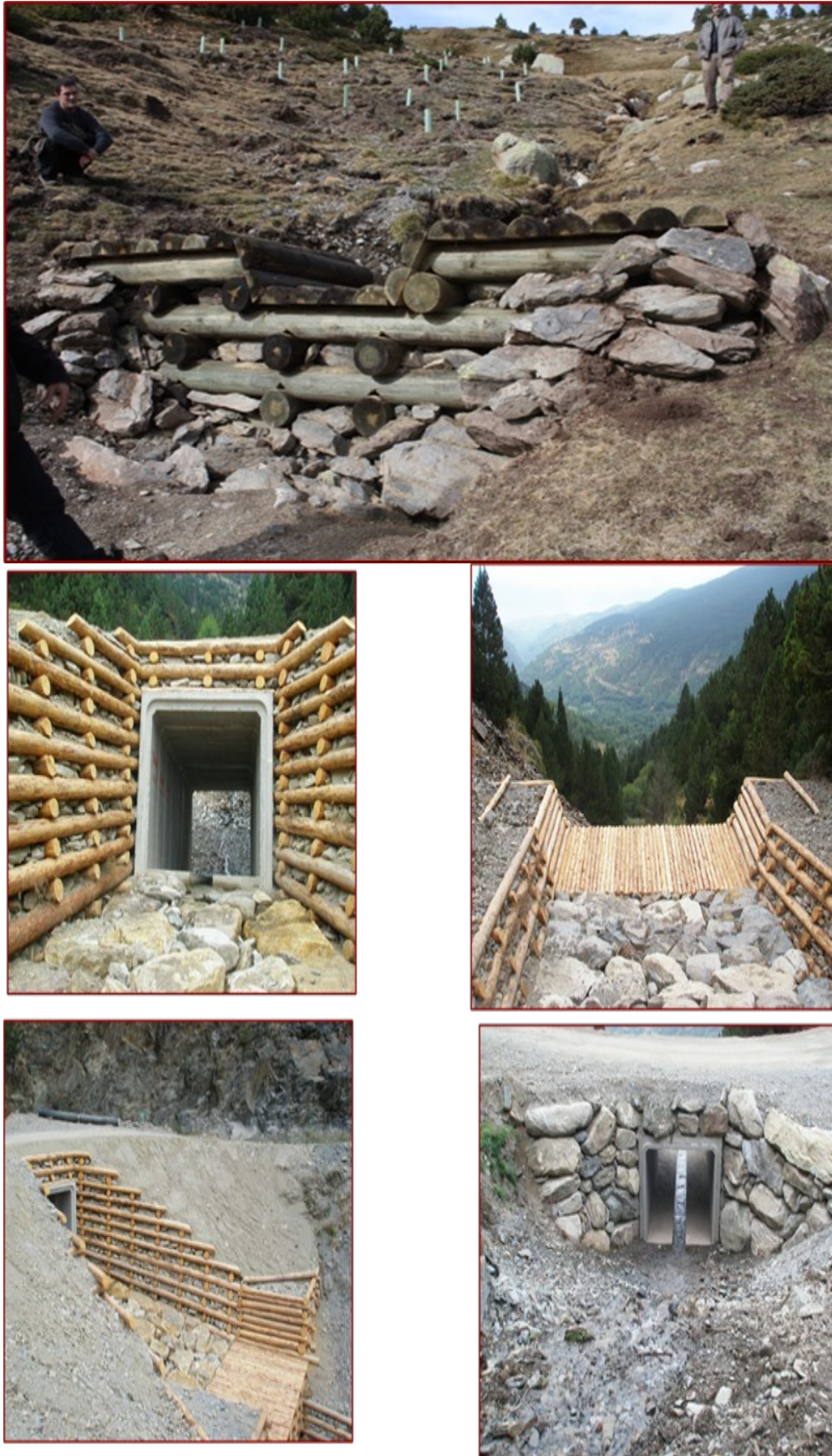
Figura 12: Fotos de la ejecución de las obras de bioingeniería.
