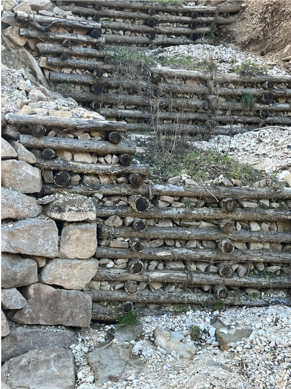
Figura 34: Foto del estado actual de las obras.
