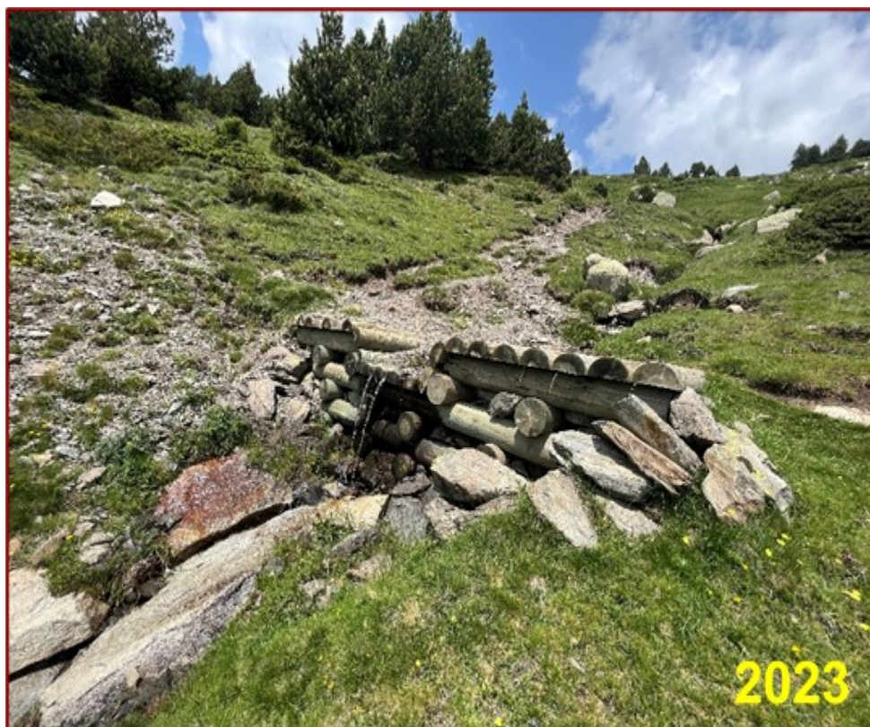
Figura 28: Foto de la evolución de los diques de consolidación y de la vegetación en la parte alta de la cuenca.
