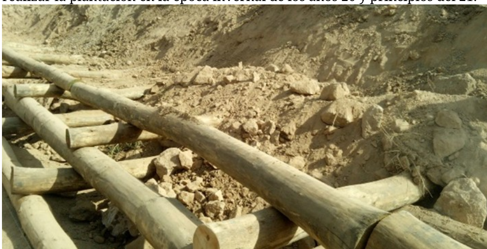
Figura 26: Foto de la ejecución de las obras de bioingeniería.
