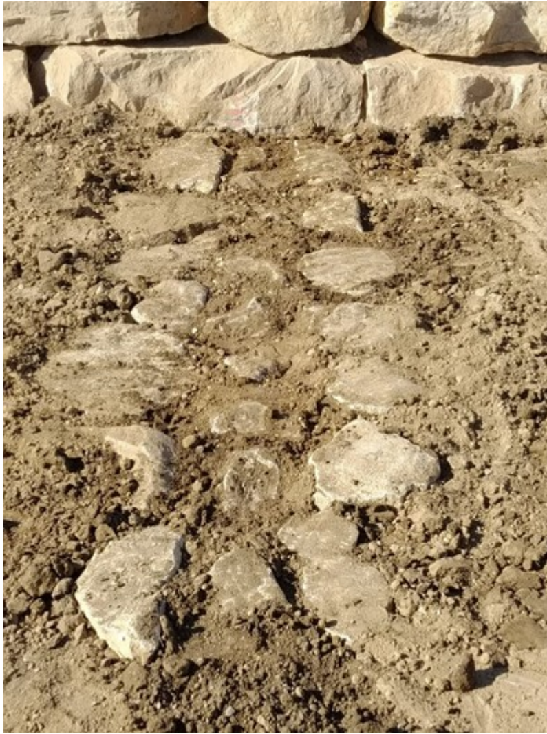
Figura 25: Fotos de la escollera y de los umbrales de fondo contruidos con piedras de escollera sin hormigonar.
